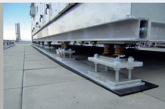
Опора для системы кондиционирования воздуха на стальных пружинах со встроенным демпфером (Isotop® DSD)
