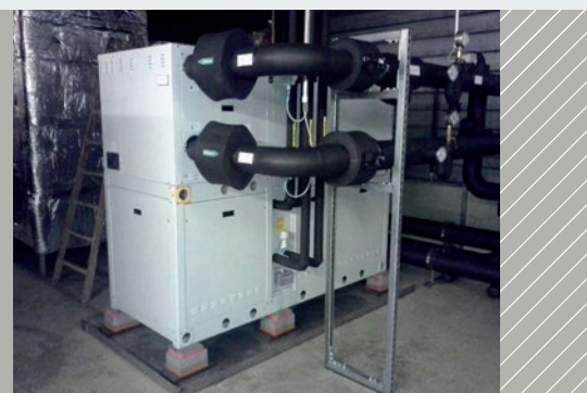
Опора для холодильной машины с использованием Isotop® SE-DE
