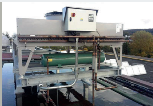
Упругая изоляция для градирни с использованием элементов Isotop® DZE
