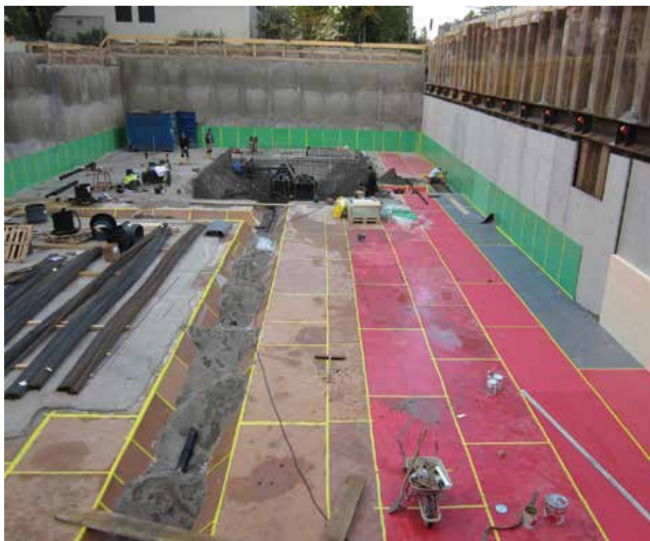
Рис. 1. Укладка виброизоляционных матов перед устройством фундамента
