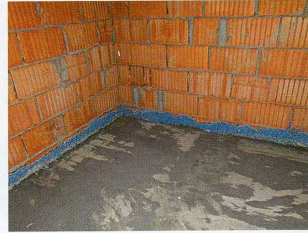
Звукоизоляционный пол по ШУМОПЛАСТУ
