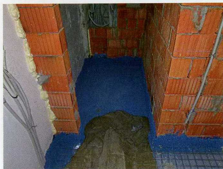
Устройство стяжки по ШУМОПЛАСТУ
