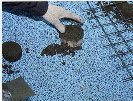
Установка маяков для армирующей сетки выравнивающей стяжки
