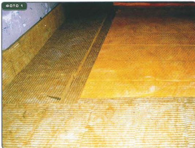
РАСКЛАДКА ПЛИТ «ШУМОСТОП-С2» И «ШУМОСТОП-К2» ПЕРЕД УСТРОЙСТВОМ СТЯЖКИ ПЛАВАЮЩЕГО ПОЛА
