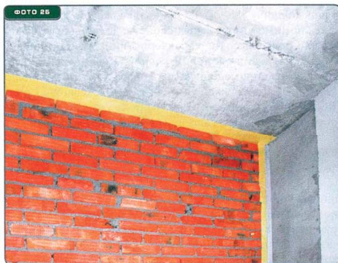
УСТРОЙСТВО ИЗОЛЯЦИИ СТРУКТУРНОГО ШУМА ДЛЯ КИРПИЧНОЙ ПЕРЕГОРОДКИ:
