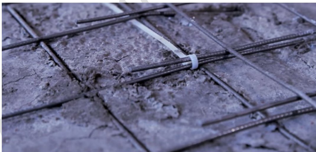
Рисунок 17. Перевязка металлической сетки.
