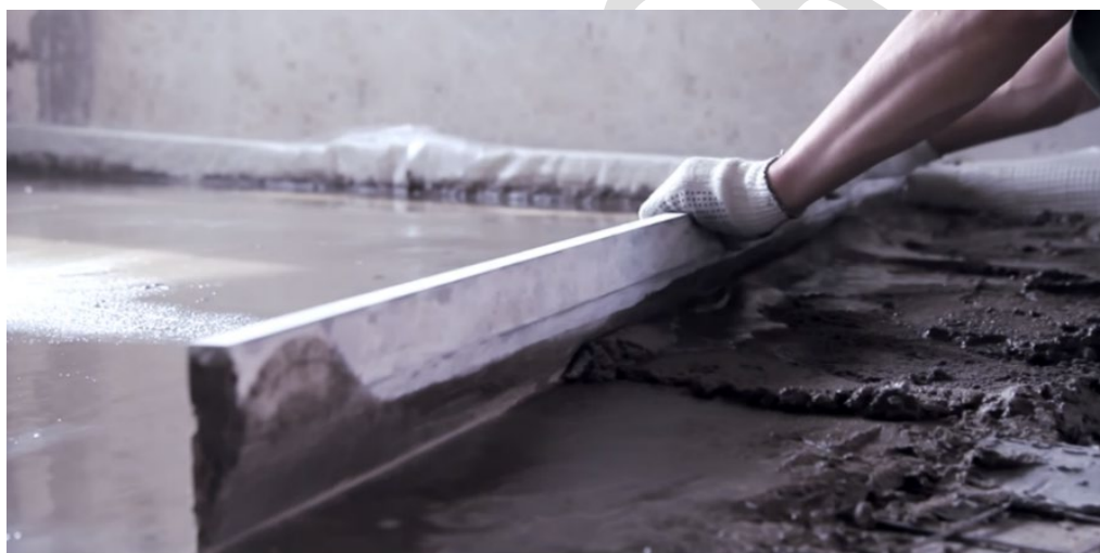
Рисунок 19. Выравнивание поверхности раствора.
