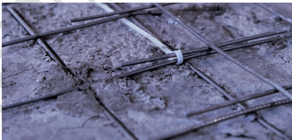
Рисунок 33. Перевязка металлической сетки.
