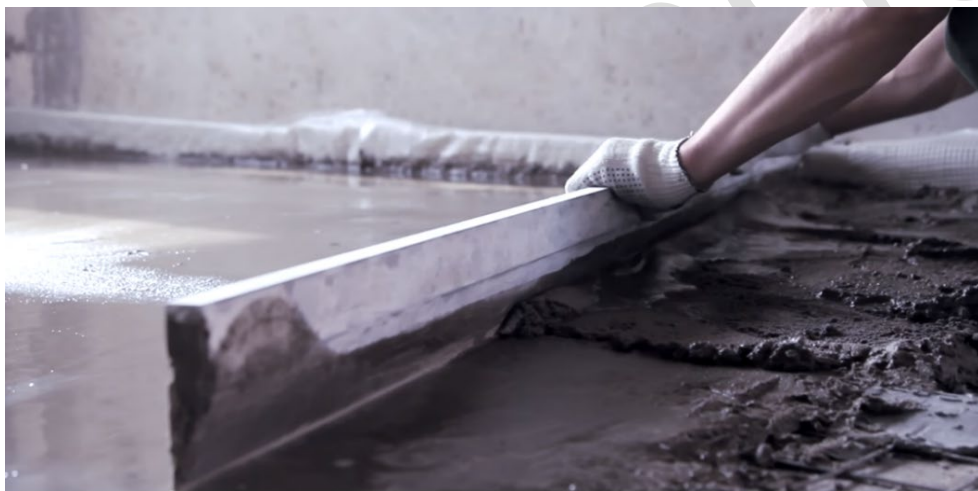
Рисунок 35. Выравнивание поверхности раствора.
