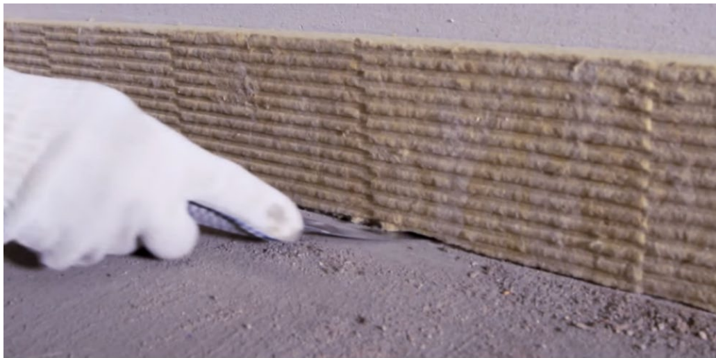
Рисунок 36. Подрезка кромочного слоя.
