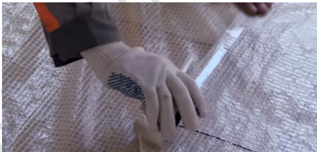
Рисунок 30. Проклейка стыков плёнки армированным скотчем.
