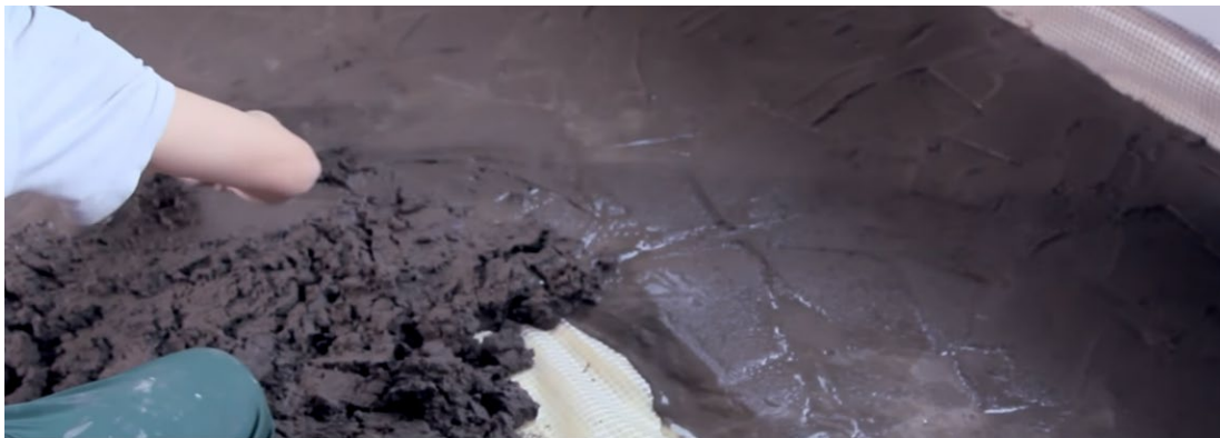
Рисунок 31. Укладка пескобетонной смеси.
