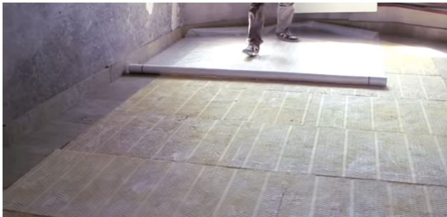
Рисунок 28. Укладка армированной полиэтиленовой плёнки.
