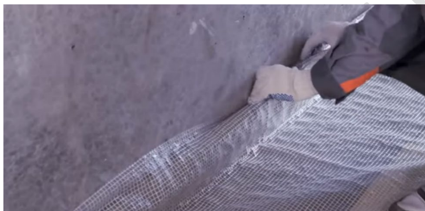
Рисунок 29. Заведение армированной полиэтиленовой плёнки за кромочную плиту Шумостоп-К2.
