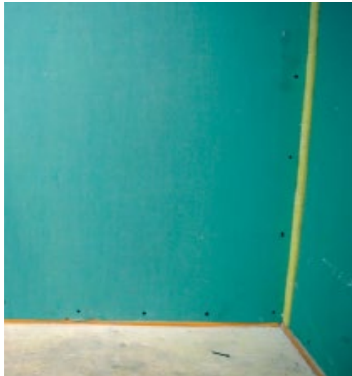
Рисунок 23. Финишный слой Гуркос АКУ-line/АКУ-line PRO.
