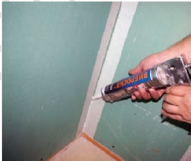
Рисунок 24. Заполнение швов герметиком Вибросил.
