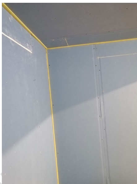
Рисунок 22. Финишный слой Gyproc AKU-line/AKU-line PRO.
