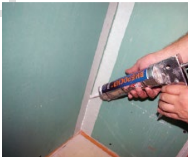
Рисунок 23. Заполнение швов герметиком Вибросил.
