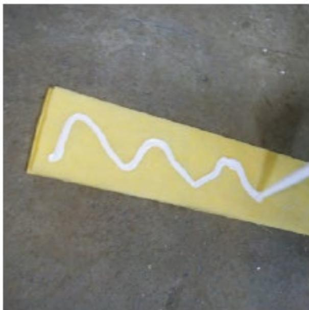
Рисунок 13. Нанесение герметика Вибросил на виброизолирующую ленту Вибростек-М.
