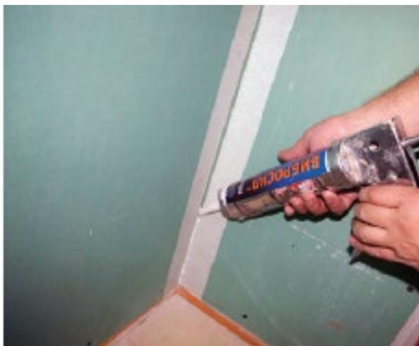
Рисунок 21. Заполнение швов герметиком.
